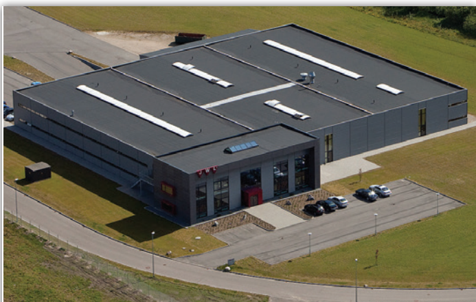
2006-07 | Bau einer neuen Fabrik in der Straße Teknikervej in Hedensted/Dänemark. Die gesamte Kompetenz unter einem Dach. Kristian Lund übernimmt im Jahre 2007 JWL.
